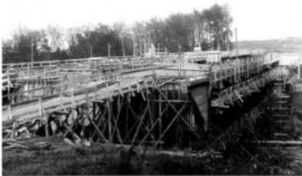
Baustelle „Isertalbrücke“ -Einschalung- (Herbst 1936) Foto: Heinz Weinreich, Penkun
