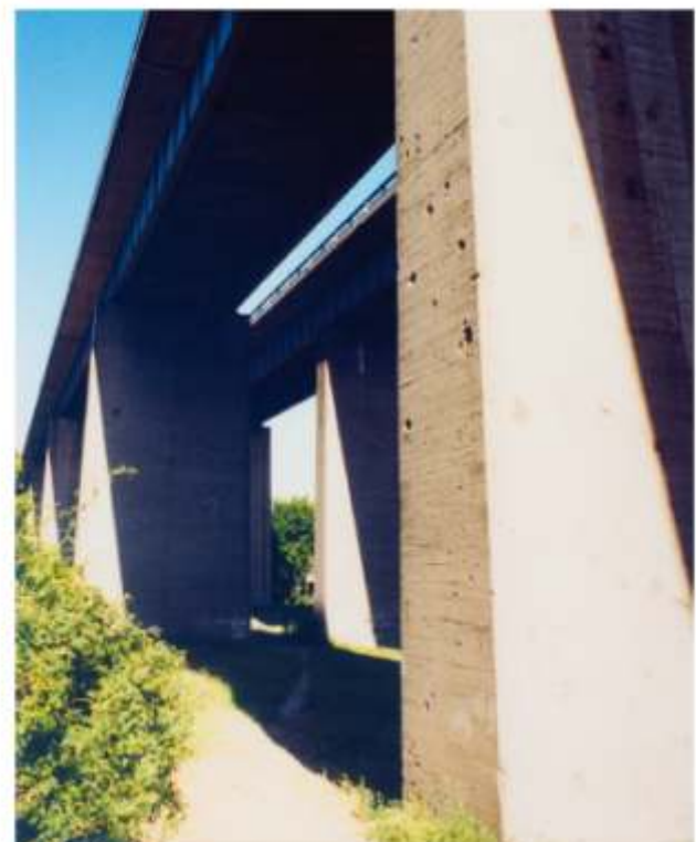
Talbrücke „Höckendorf“ (Juni 1990) Foto: Peter Gombar, Grafing
