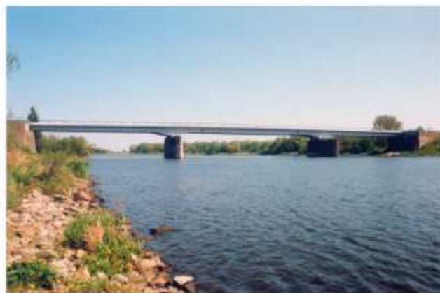
Westoderbrücke (Gesamtansicht, Juni 1990) Foto: Peter Gombar, Grafing
