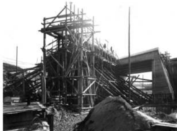
Hinterfüllung des Bauwerks an der AS „Podejuch“ (31.05.1936) Foto: Heinz Weinreich, Penkun
