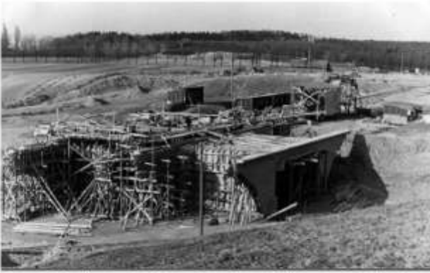
Bw am Maulbeerweg -Betonieren des 2. Rahmens- (April 1937) Foto: Heinz Weinreich, Penkun
