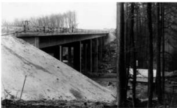
Baustelle „Isertalbrücke“ -fertiggestellte Hinterfüllung- (Mai 1937) Foto: Heinz Weinreich, Penkun
