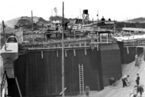
Bw am Maulbeerweg -Hinterfüllung des Bauwerks- (1937) Foto: Heinz Weinreich, Penkun
