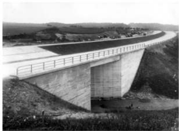
Bauwerk an der AS „Podejuch“ mit aufgebrachter Fahrbahn (Juli 1937) Foto: Heinz Weinreich, Penkun
