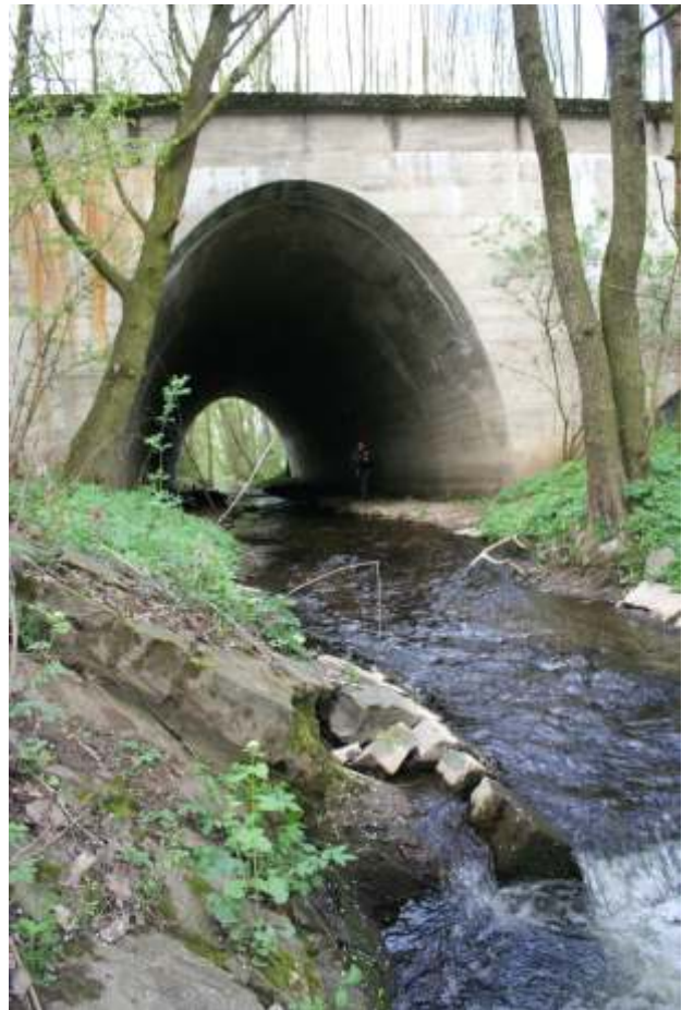
Dabei stellten wir fest, dass die rund 70 Jahre alten Brücken sich in einem erstaunlich guten Zustand befinden.
