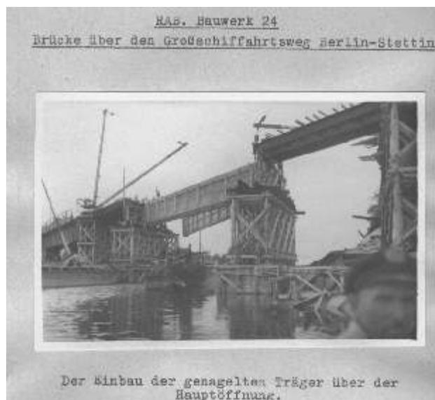
Der Einbau der genagelten Träger über der Hauptöffnung.
