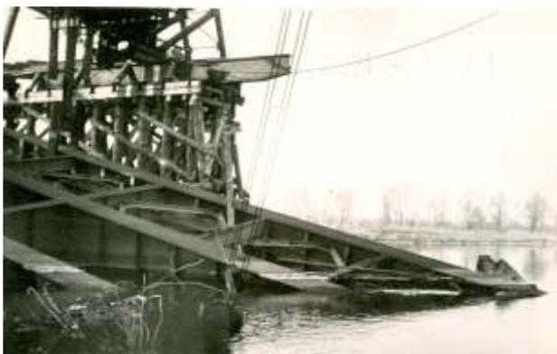
Dahmebrücke mit montiertem Hubjoch zum Heben der Träger
